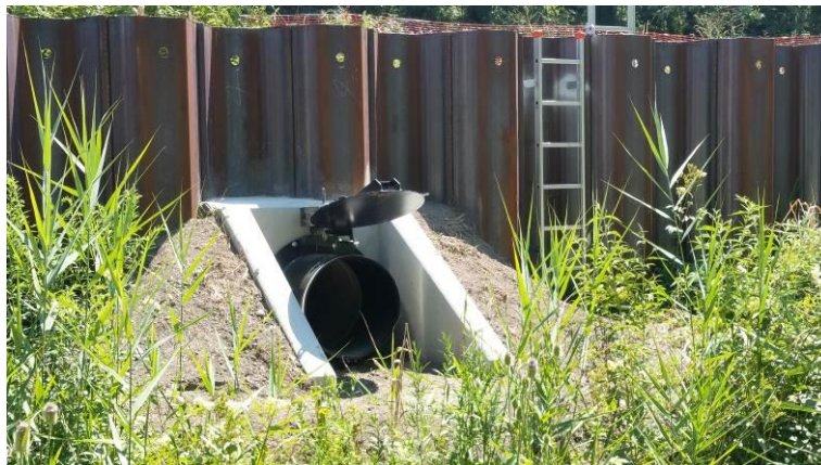
Photo n°4 : Dispositif de fermeture du passage à petite faune de la digue du chemin de fer, en cas d'inondation (CEN Isère)
