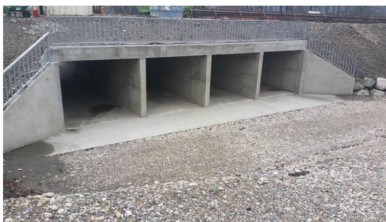
Photo n°1 : Ouvrage de vidange du casier d'inondation (CEN Isère)
